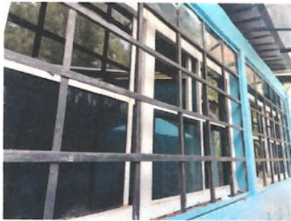
Foto 2: Reparación o sustitución de barandales metálicos, incluyendo fijaciones, pintura y soldaduras.
