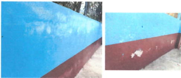
Foto 6: Reparación de repello y cernido en muro de mamposteria con aplicacion de acabado uniforme y colocación de pintura en muros.
