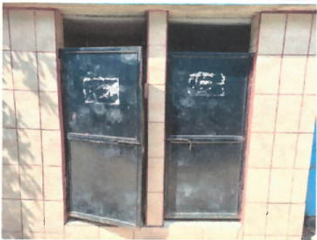
Foto 3: Mantenimiento a puerta metálica existente retiro de óxido, suciedad y pintura deteriorada; incluye cepillado, lijado y aplicación de pintura.
